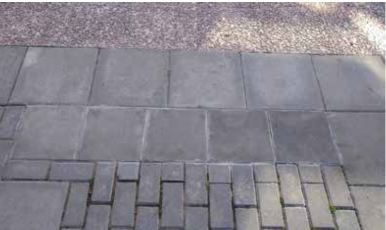
Pavimento urbano en el que se ha valorizado con esta innovación residuos textiles que habrían sido incinerados como refuerzo del cemento
