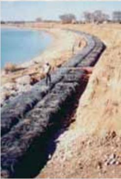
los requisitos técnicos, la construcción de una capa drenante precisa de la utilización de un relleno de permeabilidad superior a 10-3 m/s. Los rellenos de NFU troceados presentan permeabilidades del orden de 10-2 a 10-1 m/s, y por lo tanto resultan un material muy adecuado para este uso.
