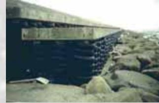
to...). Incluso su utilización en capas de espesor reducido interpuestas entre el muro y un relleno de tierras convencional permite limitar las presiones sobre la estructura. En esta aplicación se combinan las ventajas aportadas por la elevada drenabilidad del material, que permite disipar las presiones de origen hidráulico.
