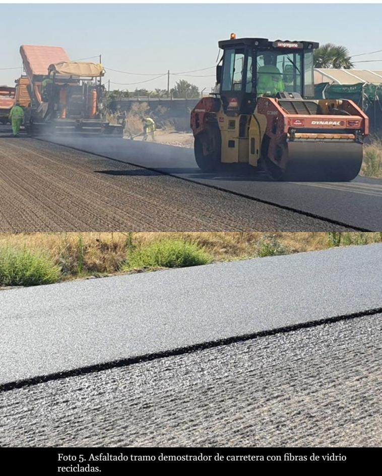
Foto 5. Asfaltado tramo demostrador de carretera con fibras de vidrio recicladas.
